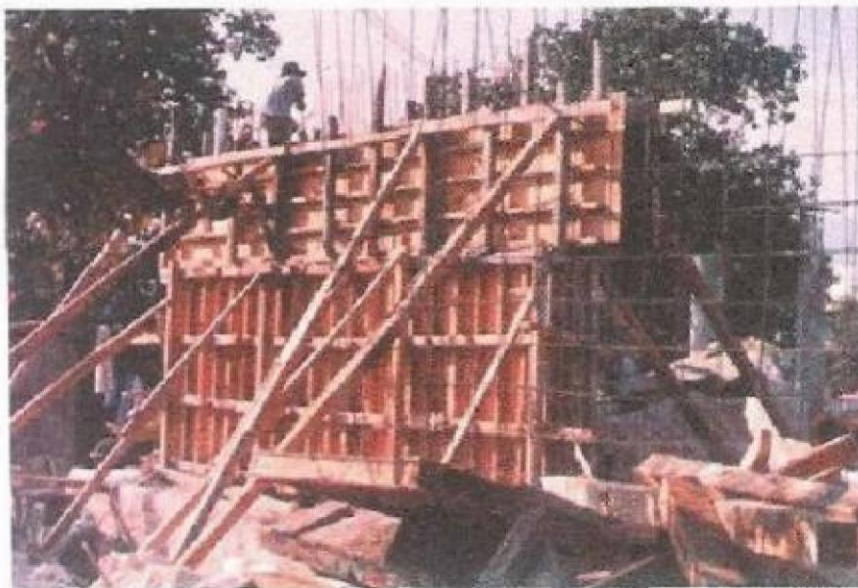
Foto No 1. Cimbrado muro frontal de concreto.
